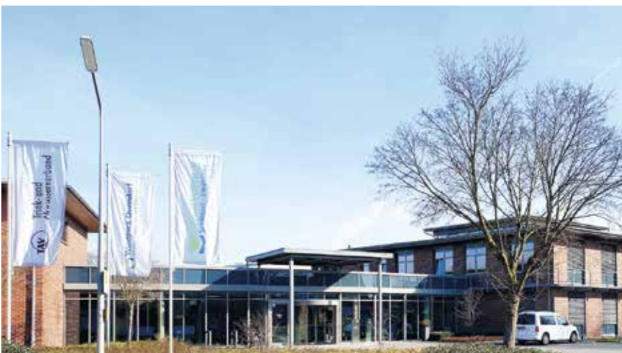
In Schüttorf und Emsbüren arbeiten Stadtwerke und Abwasserverband digital.
